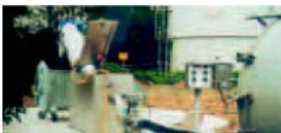
Stacja zlewczna ROTAMAT® Ro 3.2 zintegrowana z mikrositem, ogrzewana i zabezpieczona przed przemarzaniem
