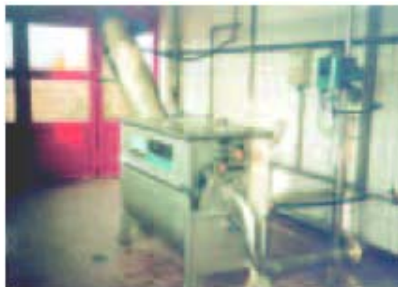
Stacja zlewca HUBER ROTAMAT® Ro 3 zamontowana w pomieszczeniu zamkniętym
